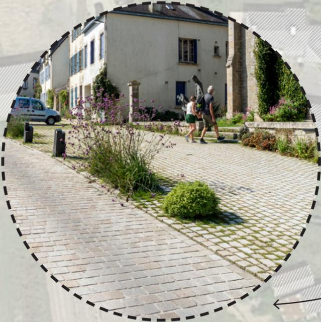
Revêtement en pavé granit joints ciment et joints enherbés
