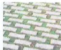
Pavage en béton avec ouvertures de drainage
