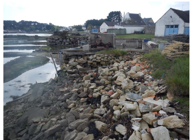
Terre-plein détruit ; Le bourg
