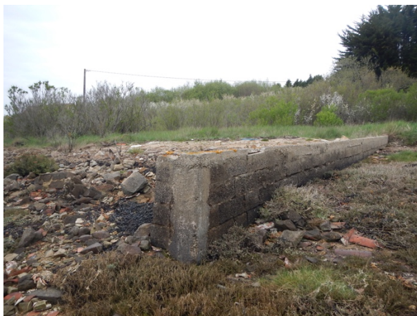
Terre-plein détruit ; Kerlioret
