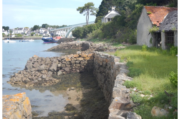
Terre-plein dégradé ; Kernivilit
