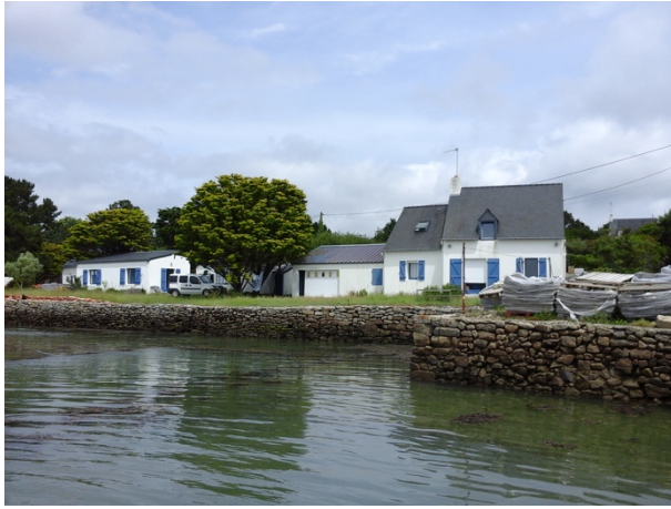
Terre-plein en bon état de conservation ; Kervat
