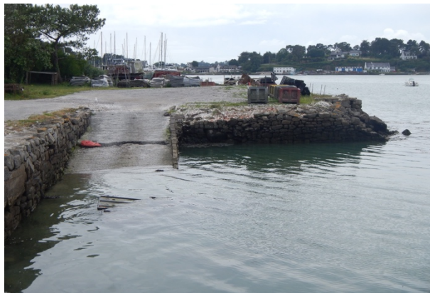
Terre-plein dégradé ; Kervat
