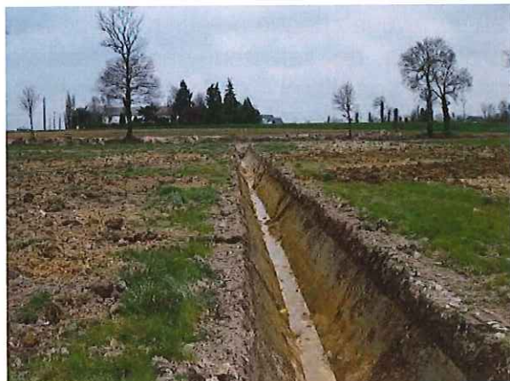
Photo 15. Drainage d'une parcelle humide (à proscrire)
