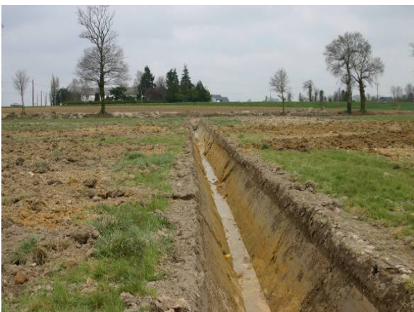
Photo 15. Drainage d'une parcelle humide (à proscrire)
