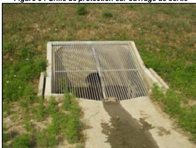
Figure 6 : Grille de protection sur ouvrage de sortie
